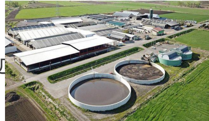
バイオガスプラント
