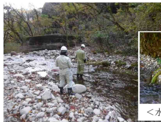
＜流量調査状況＞
