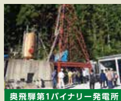
奥飛驒第1バイナリー発電所
